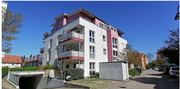
Picture: Gebäudeforum Klimaneutral
