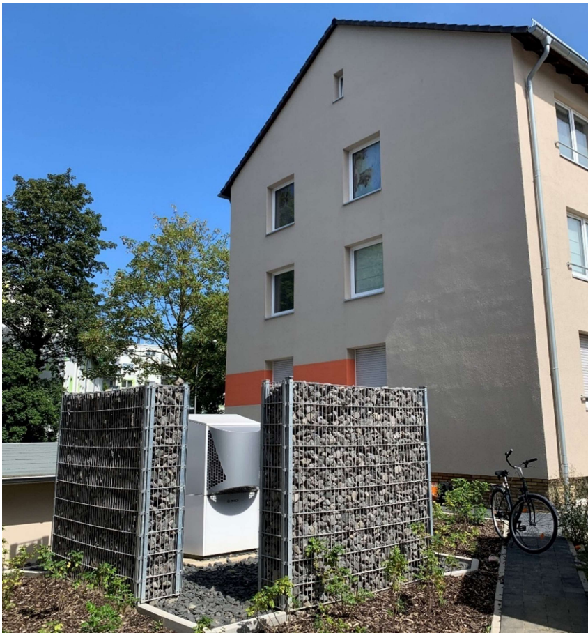
Wärmepumpe mit Schallschutz Haus 25,27
